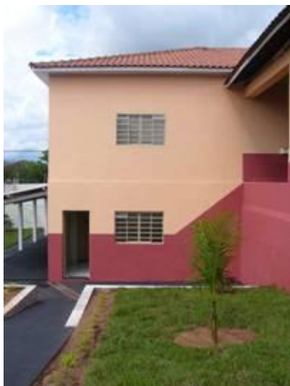
Vista externa das salas construídas
