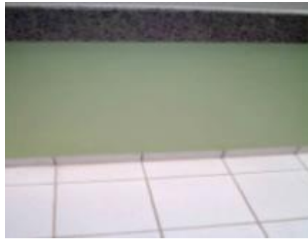
piso após a reforma
