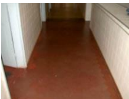
Corredor do hospital antes da reforma
