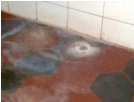
piso antes da reforma
