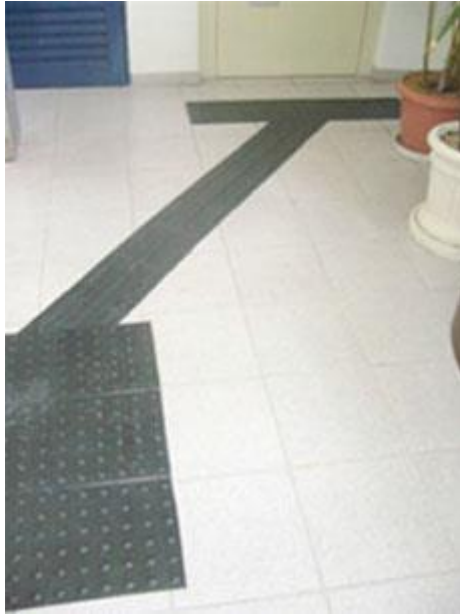
廊下誘導ブロックとエレベータ 前警告ブロック
