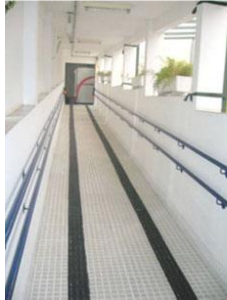
改修後（手すり、誘導ブロック 設置）
