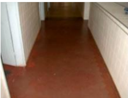
改修前の病院内通路
