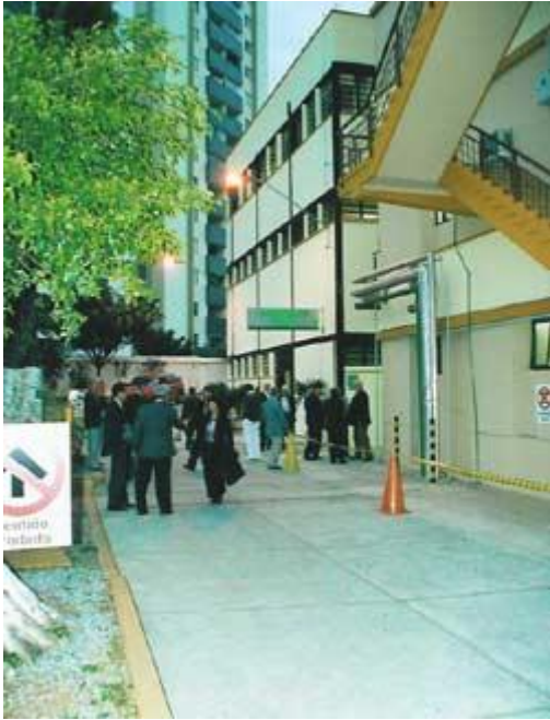
完成した同病院別棟（奥の建物）
