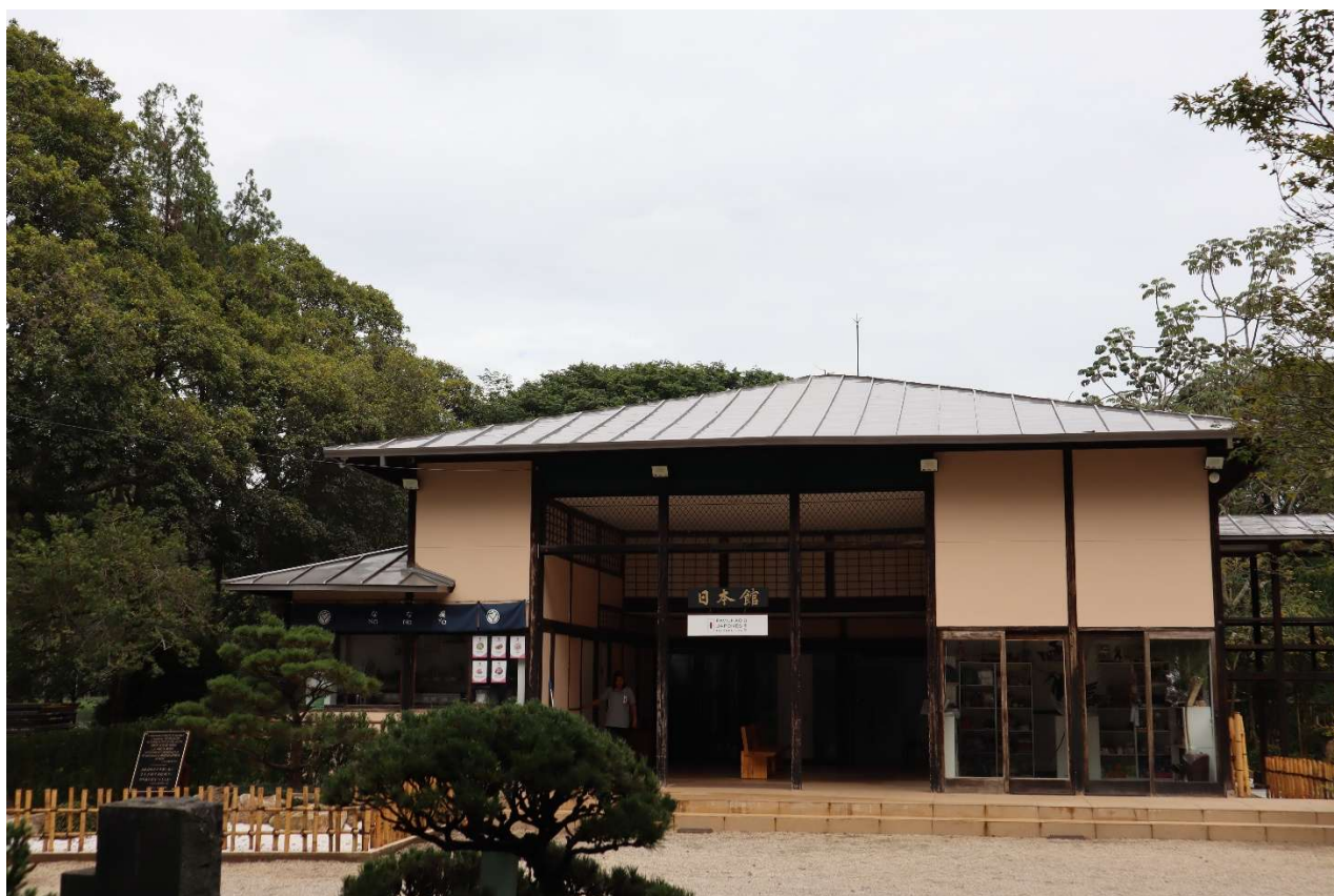
修繕後の様子
