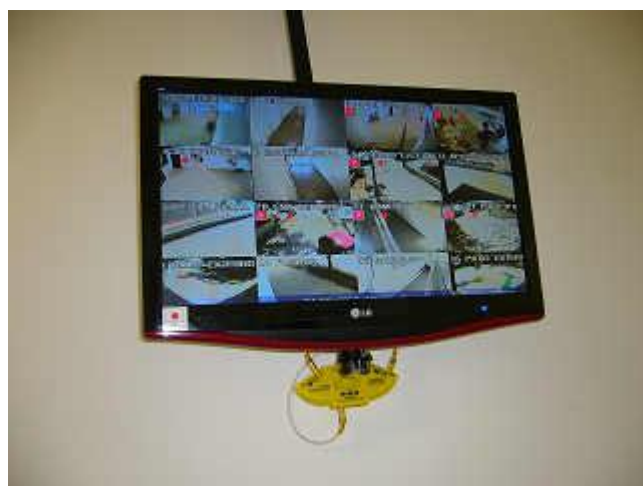
Sistema de monitoramento de câmera
